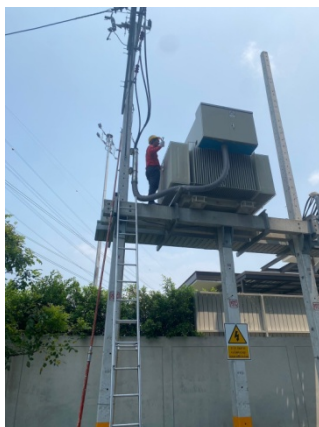
รูปที่ 2-32 การตรวจสอบหม้อแปลงและระบบไฟฟ้า
