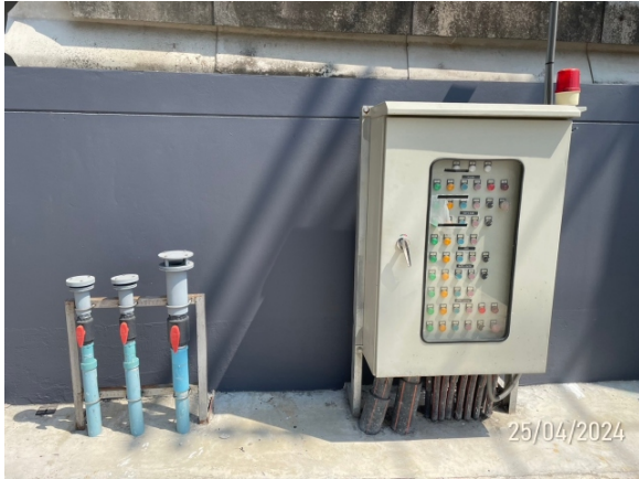
รูปที่ 2-18 ตู้ CONTROL ระบบบำบัดน้ำเสีย
