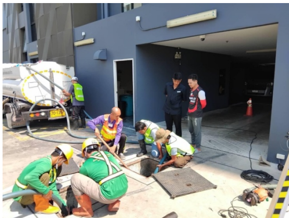
รูปที่ 2-17 การสูบล้างและกากไขมัน
