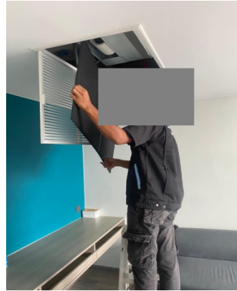
รูปที่ 2-36 การล้างทำความสะอาดเครื่องปรับอากาศ
