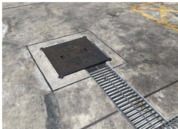
รูปที่ 2-29 รางระบายน้ำจากห้องพักมูลฝอยรวม
