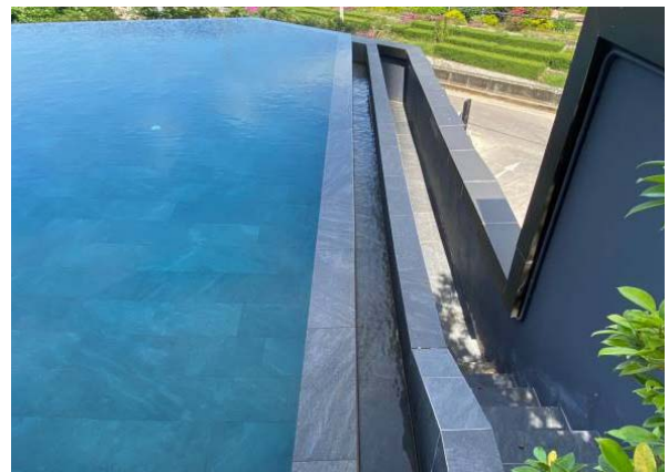
รูปที่ 2-61 รางระบายน้ำล้นรอบสระว่ายน้ำ
