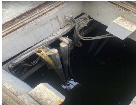
รูปที่ 2-16 ป้อนเติมอากาศชุดสำรอง
