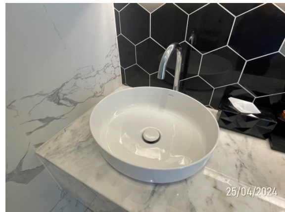
รูปที่ 2-12 ก๊อกน้ำเปิด-ปิด แบบอัตโนมัติ
