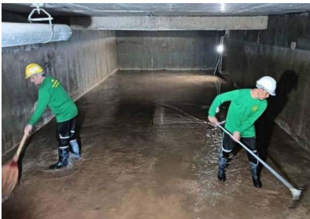
รูปที่ 2-13 การทำความสะอาดถังสำรองน้ำใช้
