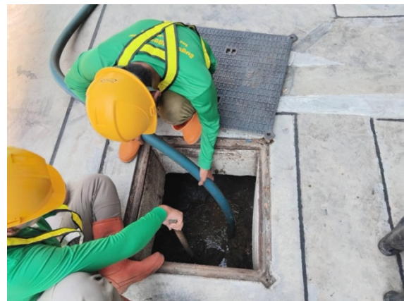
รูปที่ 2-17 การสูบล้างและกากไขมัน
